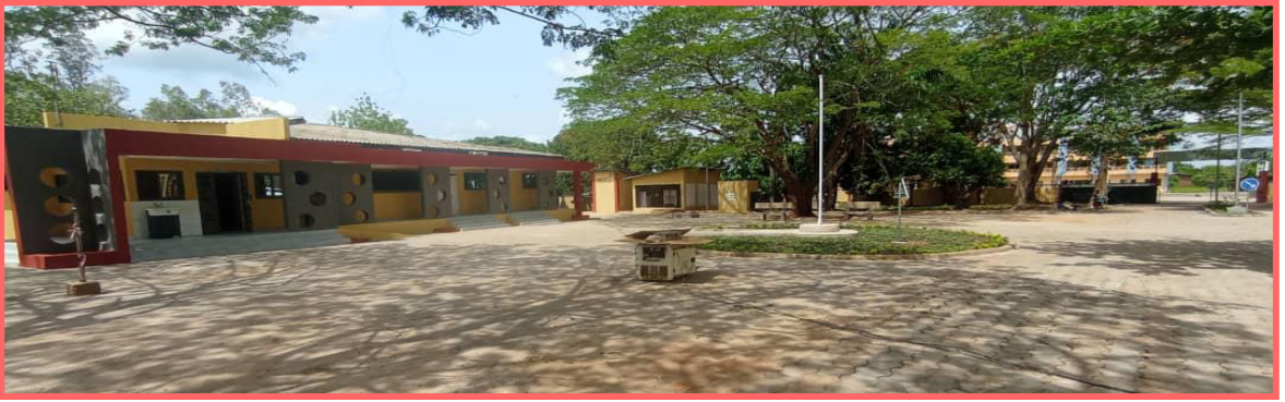
Cour centrale du LABOVET réhabilitée
